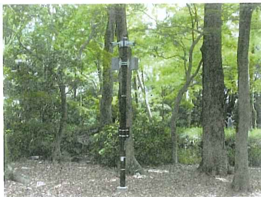
カメラ増設及び放送設備設置
