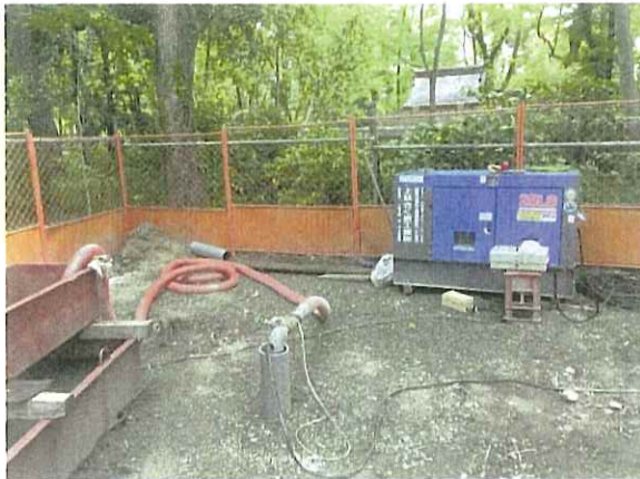
井戸さく井工事
