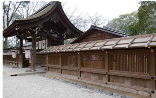
河合神社 東西透塀工事完了
