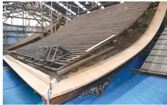
蛇腹板の取り付け
