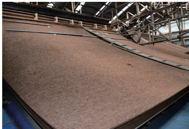
葺き替えられた本殿屋根
