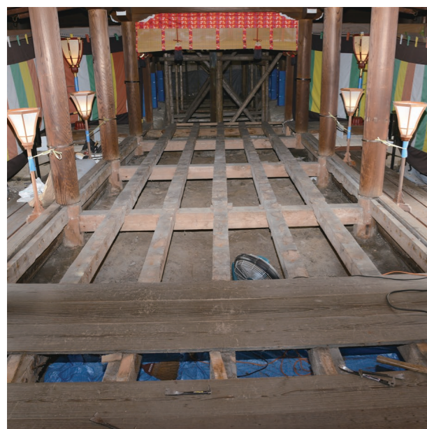
木部の補修を行う祝詞舎床板
