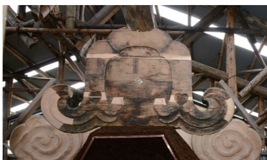
一部新しい木材で補修された本殿鬼板
