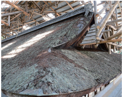
傷みが激しい檜皮屋根
