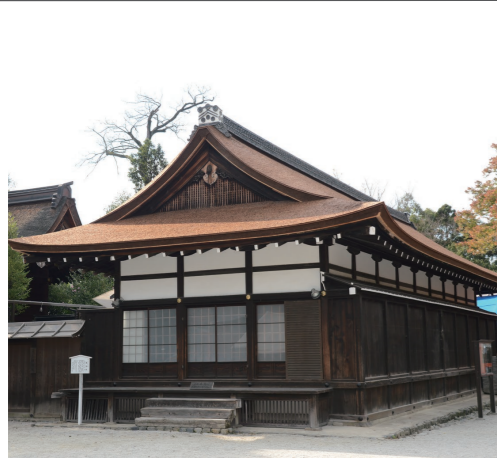
屋根が葺き替えられた供御所
