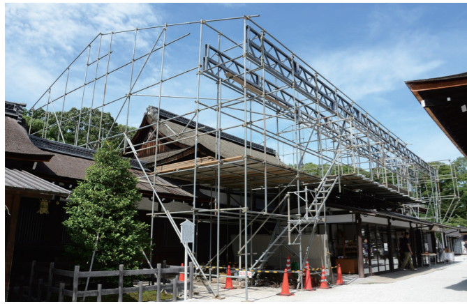
預屋に素屋根が組まれる
