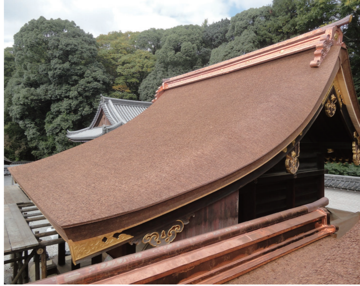
檜皮葺屋根の完成(西本殿)
