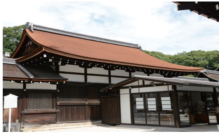
修理後(葺き替えられた檜皮屋根)
