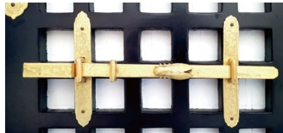
図3 蟬樞の付いた蒔戸(大覚寺宸殿)
